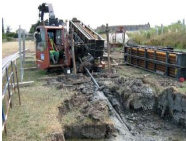
Illustration 12 : Chantier forage dirigé
