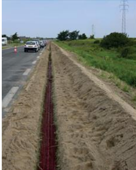
Illustration 8 : Tranchée avec fourreaux en PEHD
