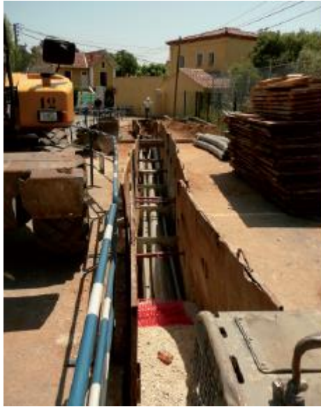
Illustration 9 : Mise en place de fourreaux PVC
