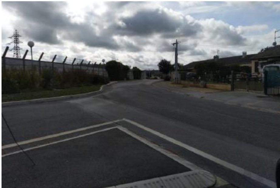
Illustration 3 : Départs depuis le poste RTE
